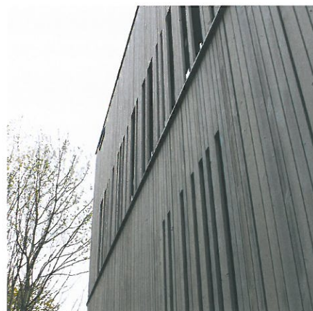
Die Holzlattung der Fassade ist thermobehandelt. Die Pigmente im Vorvergrauungsanstrich waschen sich mit der Zeit wieder aus.
