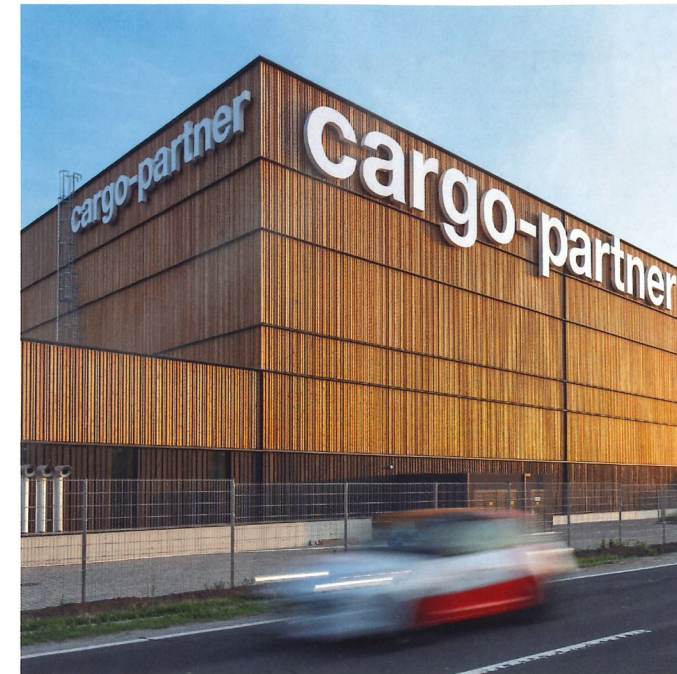
Das Gebäude in Holzbauweise ist 20 m hoch, um Platz für das komplexe Shuttlelager zu bieten.
