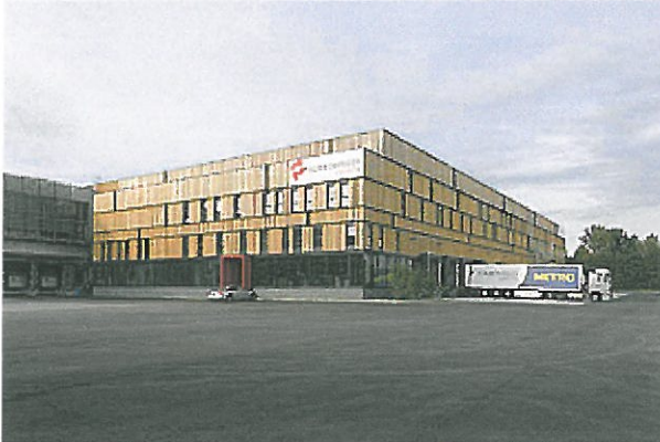
Leuchtturm 1, das zukunftsweisende Logistikgebäude von Schachinger Logistik (Außenansicht)
