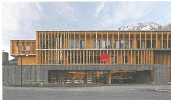
Halle und Bürogebäude Meiberger → S. 20 – 29
