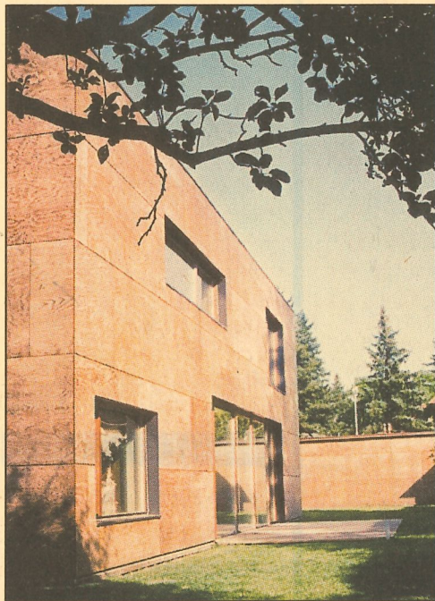
Das Haus öffnet sich mit großzügiger Verglasung und Terrasse nach Südwesten in den Garten.
