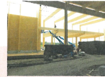
► Nächster Schritt: Die Galeriekonstruktion wird montiert
