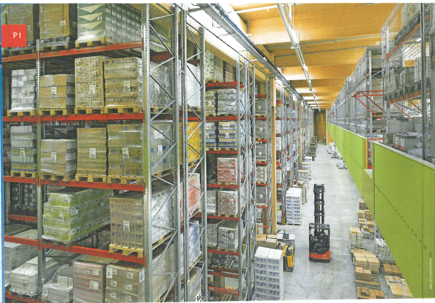
▲ Bei der Lagerhalle aus Holz war es Ziel, eine hohe Arbeitsplatzqualität zu erreichen
