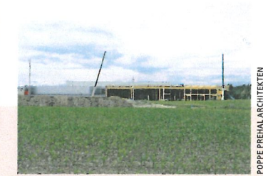
► Gut erkennbar: Der Neubau schiebt sich in den Bestand
