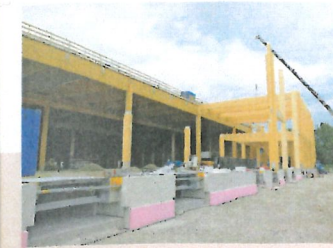
► An der Südseite sind schon die Laderampen zu erkennen
