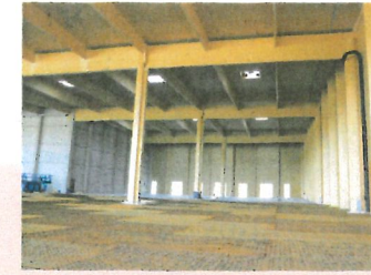
► Der Bau schreitet voran: Die Gebäudehülle steht
