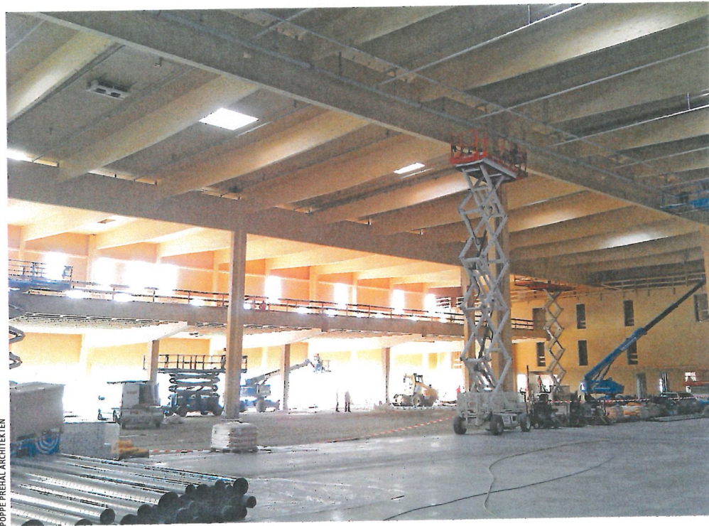
► Die Holzkonstruktion steht, nun fehlt noch der Innenausbau
