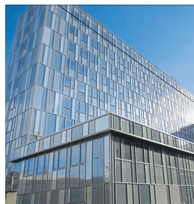
Sanierte Silbermöwe: um bis zu 60 Prozent weniger Energiebedarf. [DH Architekten]
